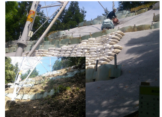
【Slope Protection 斜面保護】
